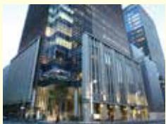
YUITO 日本橋室町野村ビル
